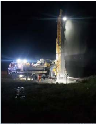
पावर ड्रिल स्यालो ट्युबवेल निर्माण कार्य जलजला गढवा दाड
