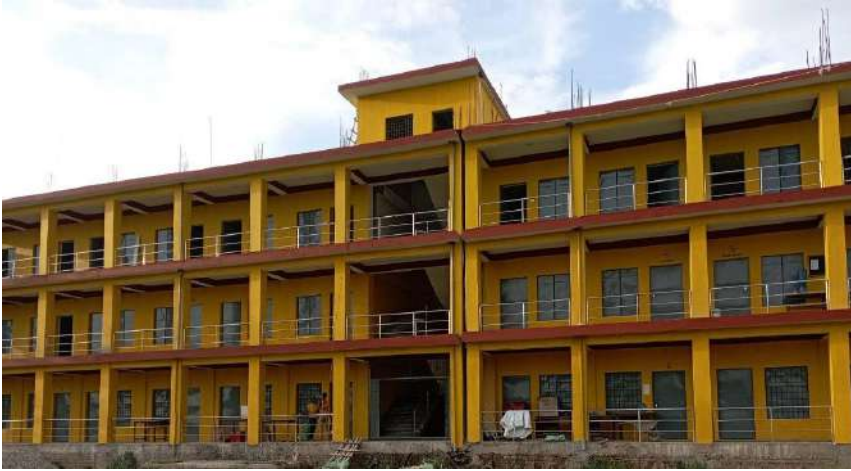
पद्मोदय क्याम्पस दाङमा भवन निर्माण
