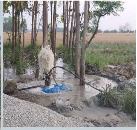
स्यालो ट्युबवेल निर्माण पश्चात डेभलपमेन्ट कार्य हुदै शिवराज कपिलवस्तु
