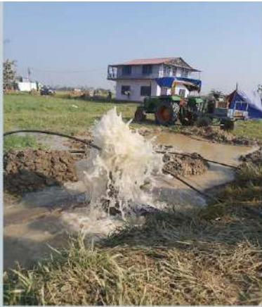
स्यालो ट्युबवेल निर्माण पश्चात डेभलपमेन्ट कार्य हुदै शिवराज कपिलवस्तु
